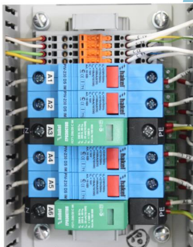
Модуль кроссовый МКр-13 (модуль грозозащиты для двух каналов, первый класс защиты)
